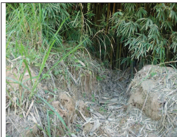
Condução do escoamento superficial da estrada para bambuzeiros
