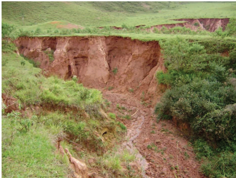
Figura 3-15 – Fluxo de água corrente no interior do dígito de uma voçoroca durante o início do período de estiagem (extraído de Sato, 2012)
